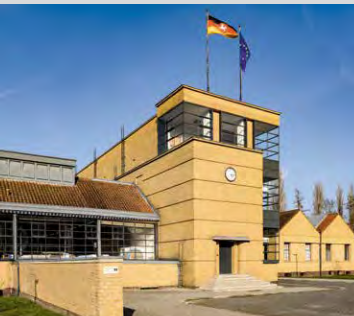
Haupteingang Fagus-Werk zur Straßenseite, zweiter Bauabschnitt
