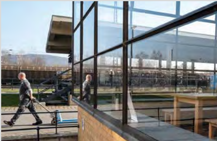
Blick auf Kantine und ehemaligen Maschinensaal(rechts) sowie auf das ehemalige Spänehaus und heutige UNESCO-Besucherzentrum
